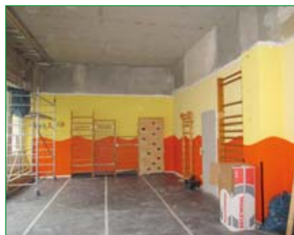
Kindersport: Einbau der neuen ballwurfsicheren Decke
